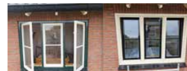
(Links oorspronkelijke kozijn - rechts bestaande kozijn geüpgradet en voorzien van draaikiepraam)
