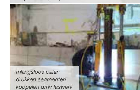
Trillingsloos palen drukken segmenten koppelen dmv laswerk
