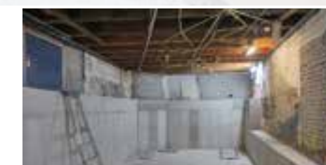
Constructieve betonvloer en -wanden gereed. Volgende stap is palen drukken
