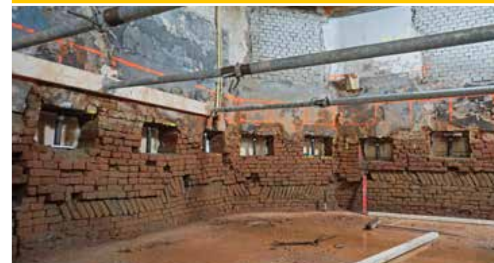
Problematiek - historisch herstel dmv metselwerk op geen enkele manier constructief recht te rekenen
