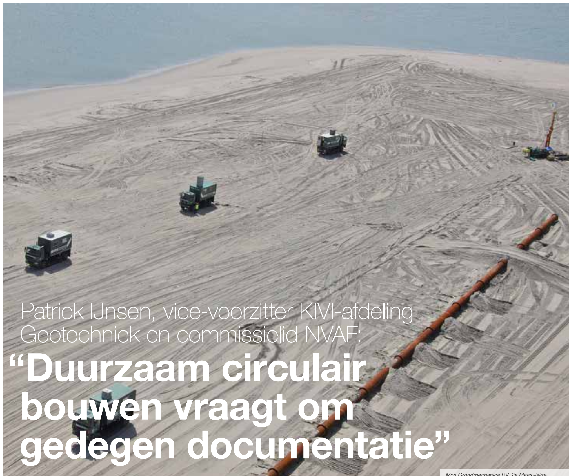
Mos Grondmechanica BV, 2e Maasvlakte
