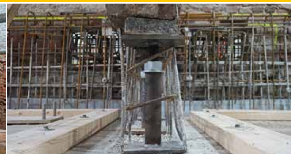
Draagmuren opvangen dmv spindels en vlechtwerk voorbereid
