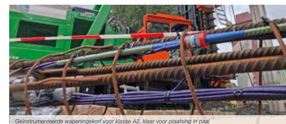
Geïnstrumenteerde wapeningskorf voor klasse A2, klaar voor plaatsing in paal
