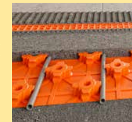
Opbouw Schlüter BEKOTEC-Therm vloer. De te storten Remix Gietvloermortel Snel komt slechts 8 - 25 mm boven de noppen en verwarmingsbuizen.
