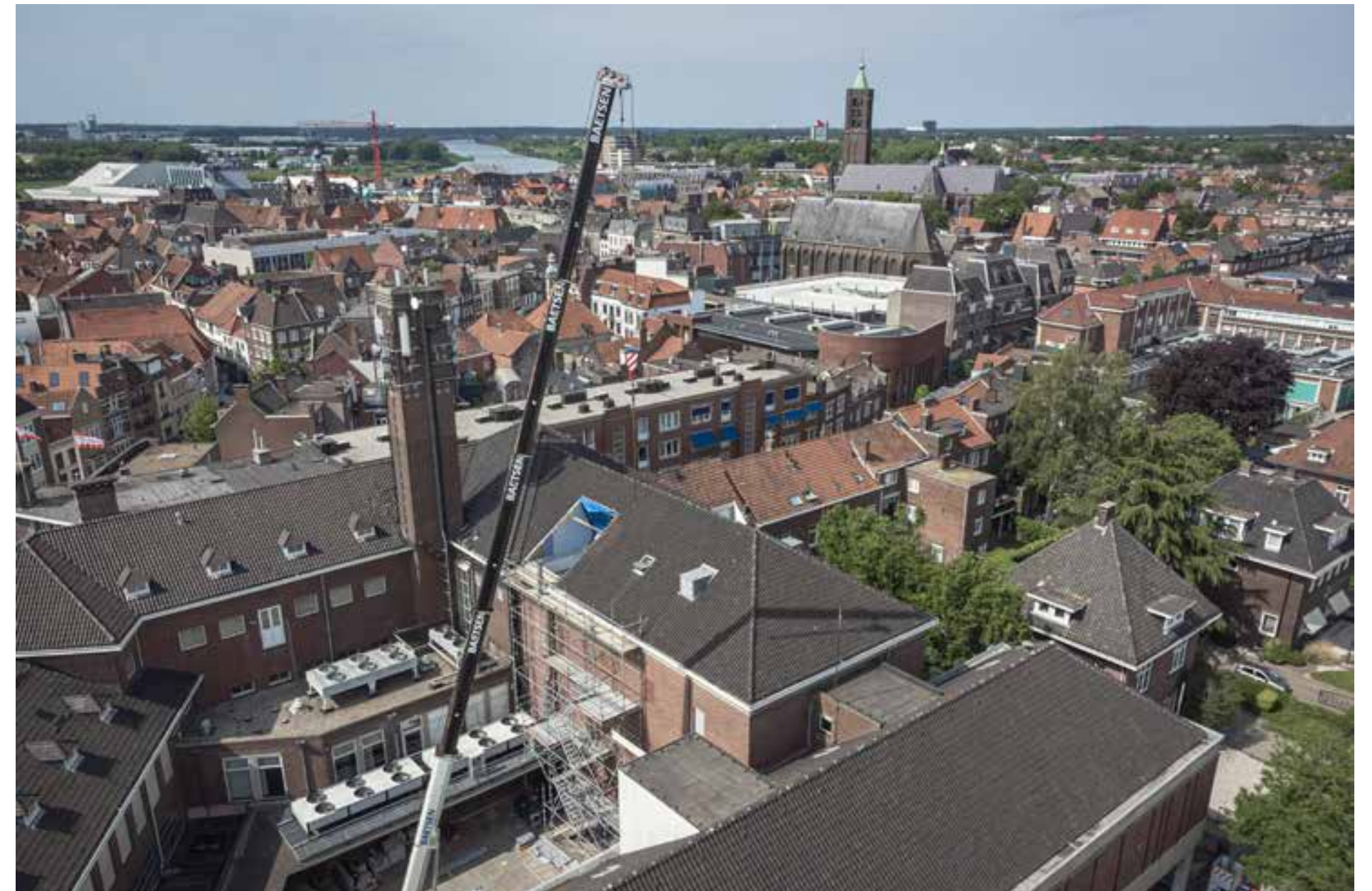
Waarom puin afvoeren als je dit direct nuttig kunt inzetten op dezelfde locatie? Pannen, panelen en houten dakbeschot wordt gebruikt om de gaten in het dak van KPN Venlo te dichten.
