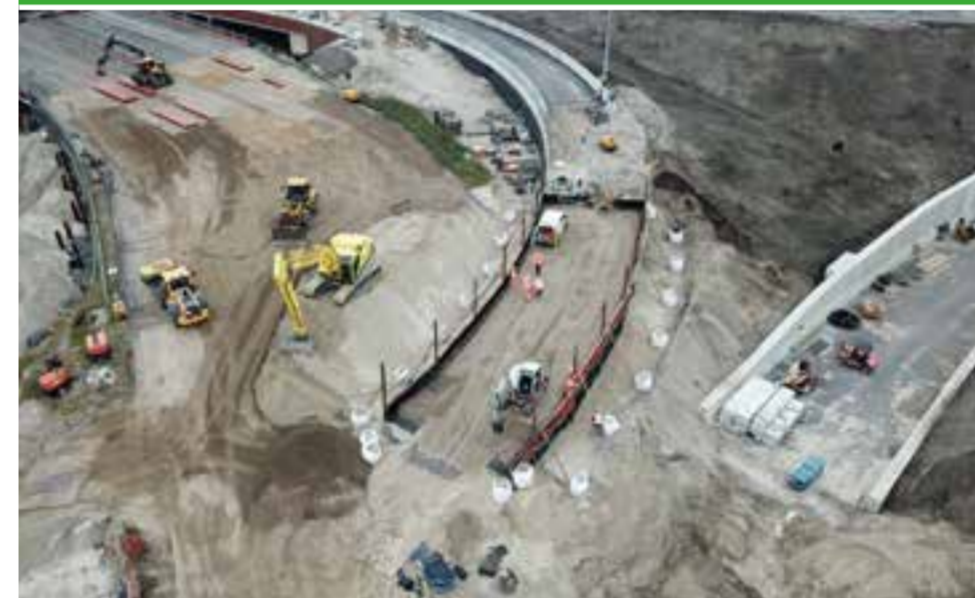
Gewapende grondconstructie in Groningen
